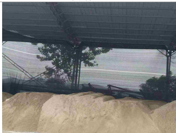
黄沙堆场采用封闭围护结构
