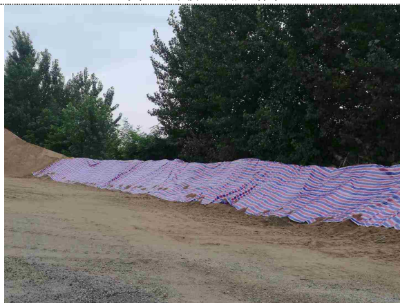
黄沙堆场采用毡布覆盖
